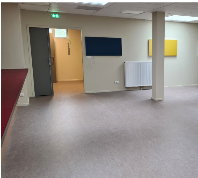
La future salle du conseil de gestion en cours d'aménagement.
