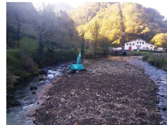
Travaux de restauration, Syndicat Mixte des Gaves d'Oloron et Mauléon
